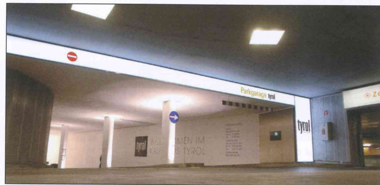
Selbst im Parkhaus wurden Led's flat eingesetzt, damit Kunden die 261 Parkplätze optimal ausnutzen.
