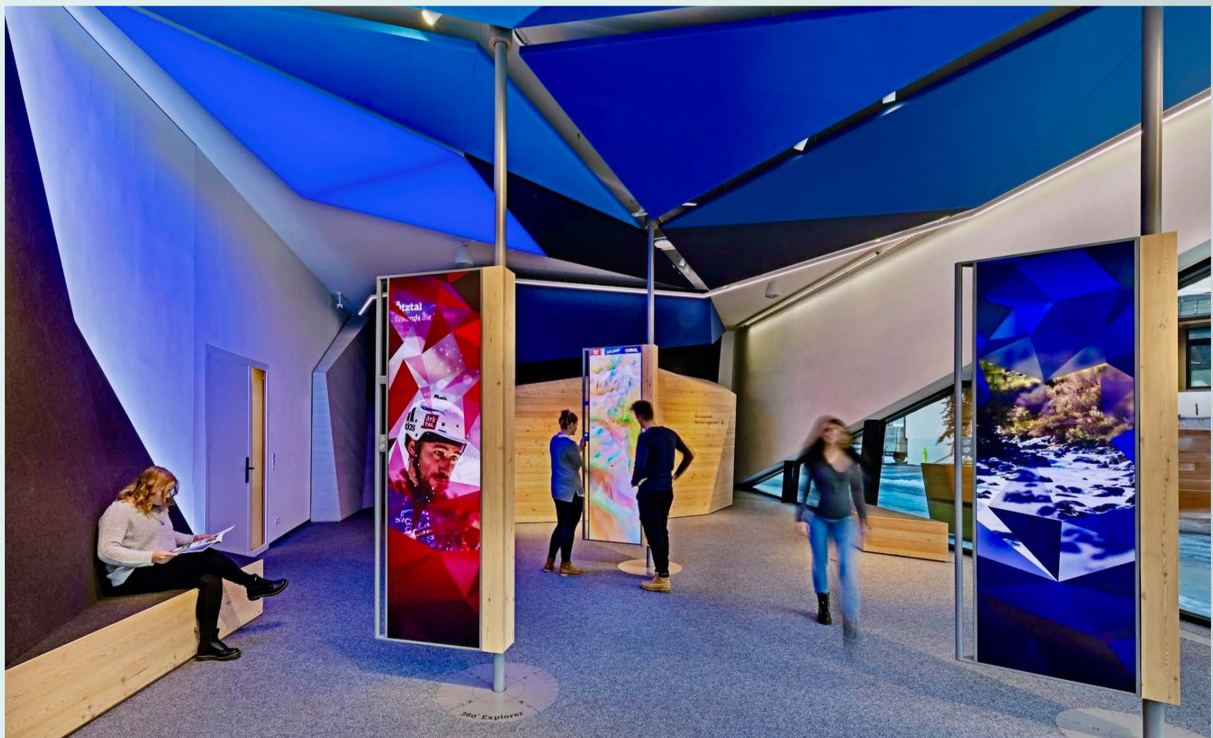
3D-Akustikelement und LED-Lichtdecken
