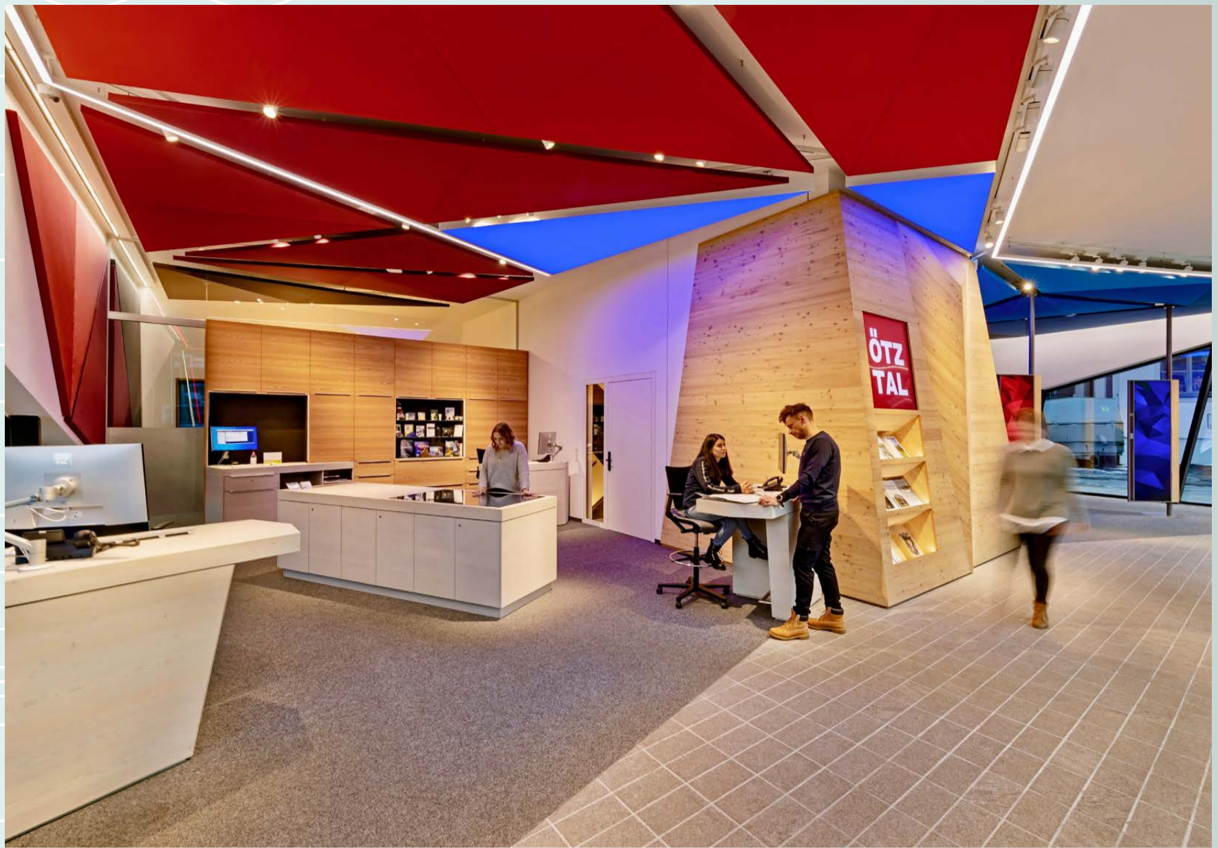
Akustikdecken, Lichtdecken integriert in das Raumdesign
