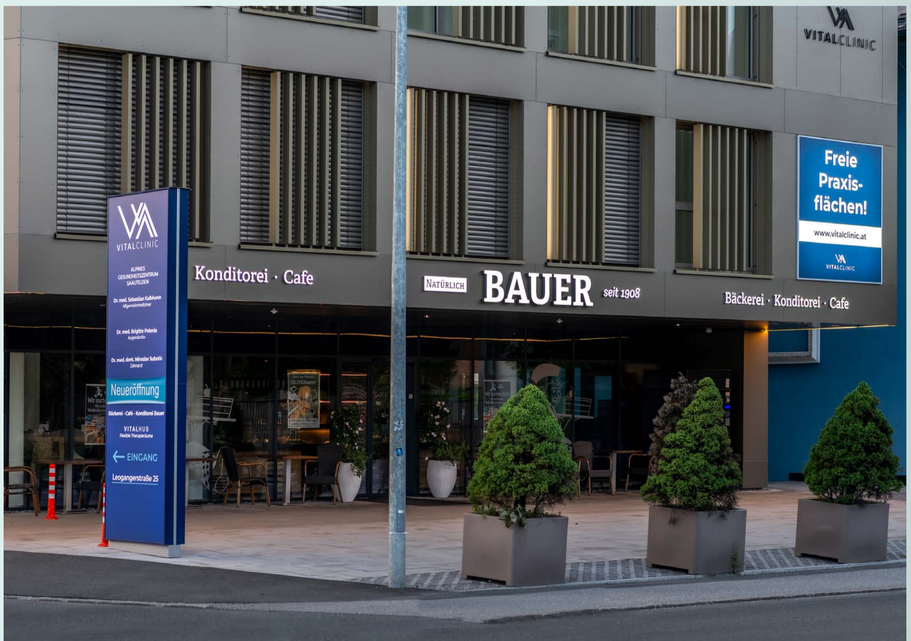
Pylon und Spannfolien-Leuchtschild
